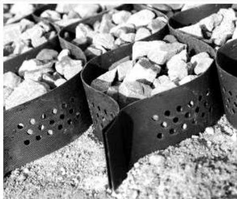
Рис. 11. Сформированные сварные швы лент георешетки.
