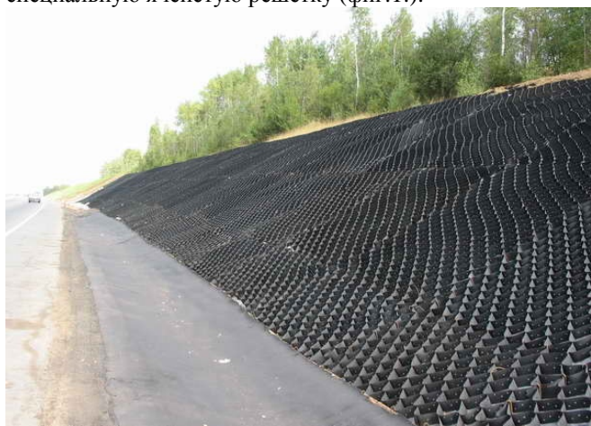
Фиг. 1 Ячеистая решетка в ландшафтном строительстве.
