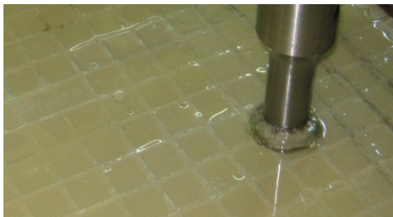
Рис. 4. Воздействие на слой эпоксидной смолы, нанесенной на внутренние поверхности каменных плит
