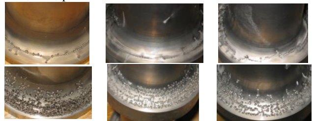
Рис.5. Неравномерный кавитационный износ модулей
